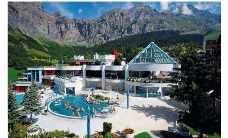
Die Gemmleitung wird rechtswidrig auf 380 Kilovolt hochgefahren – zum Schaden von Mensch und Natur. Und eine schwere Belastung für den Badekurort Leukerbad.
