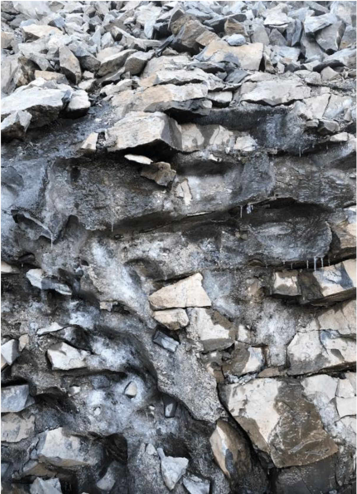
Felsbrocken, zusammengehalten von Eis: Aufnahme des Gesteins am «Spitze Stei» oberhalb von Kandersteg BE.
