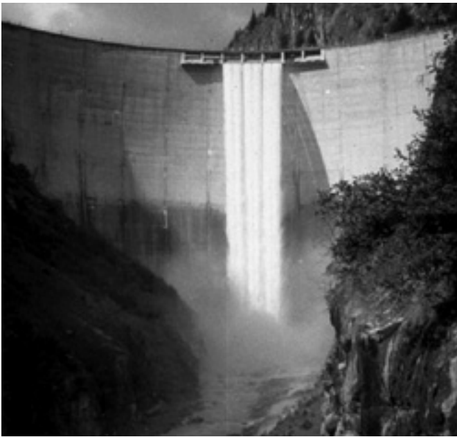
Staumauer Gebidum: Laut Vereinbarung aus dem Jahre 1975 gehört das Wasser ab dem Fuss der Staumauer den Bitschern.
