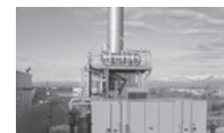
GuD Termica Vercelli (Italien)
